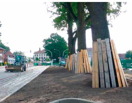
Die neue, baumfreundlichere Situation, allerdings noch ohne das Pflaster auf dem Wurzelbereich.
