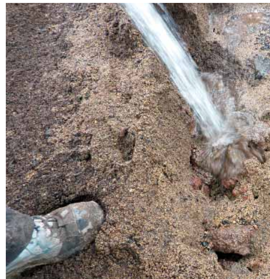
In die Hohlräume zwischen den verdichteten Groblava-Blocken wird das Bims-Xylit-Gemisch eingespült.
