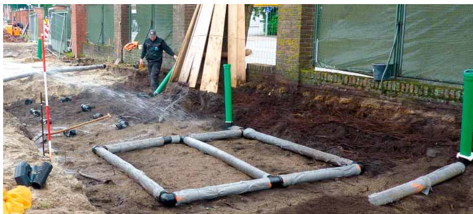
Die Belüftungs- und Bewässerungselemente bestehen aus druckstabilen, mit Geo-Textil ummantelten Dränageröhren. Sie wurden mit Bims-Xylit-Gemisch, etwa 10 cm stark, abgedeckt.
