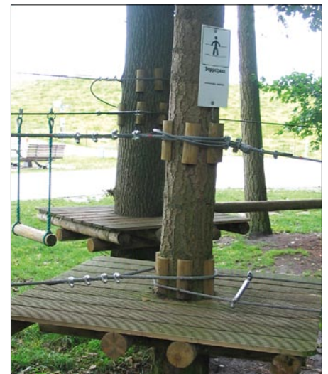
Abb. 4: Halbriegel als Abstandhalter zwischen Baum und ihm umschlingenden Seilen
