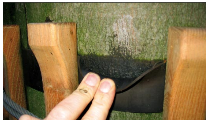
Abb. 6: Beginnende Rindennekrosen unter dem den Stamm umschließenden Gummiband der Abstandshalter eines Stahlseils.
